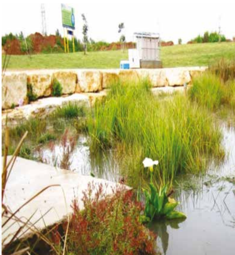
איור 40: הביופילטר לאחר אירוע גשם
