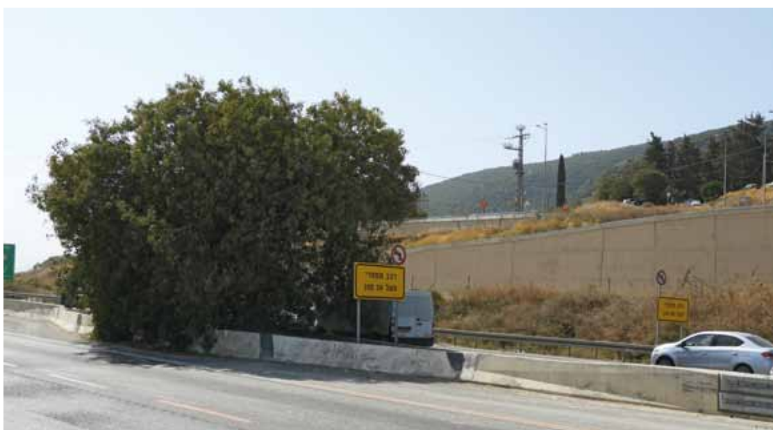
תמונה 2: עץ האלה האטלנטית בכביש 70 ליד צומת עמקים, כפי שנראה היום לאחר הרחבת הכביש שבוצעה ב-1985 (צילום: רועי הראל, 2017). Picture 2: Pistacia atlantica tree that was preserved between the lanes of road number 70 during road construction in 1985 (Photo: Roy Harel, 2017).
